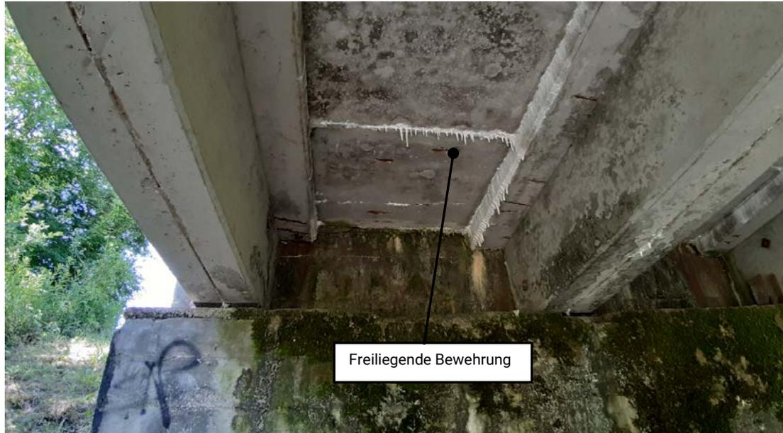
**Abbildung 17: Tragwerk Hofhamer Brücke, Widerlager Süd**
